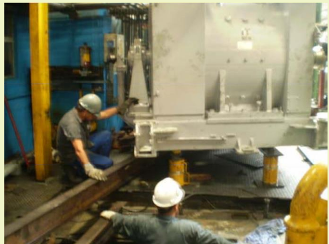
Remoção e instalação de equipamentos
