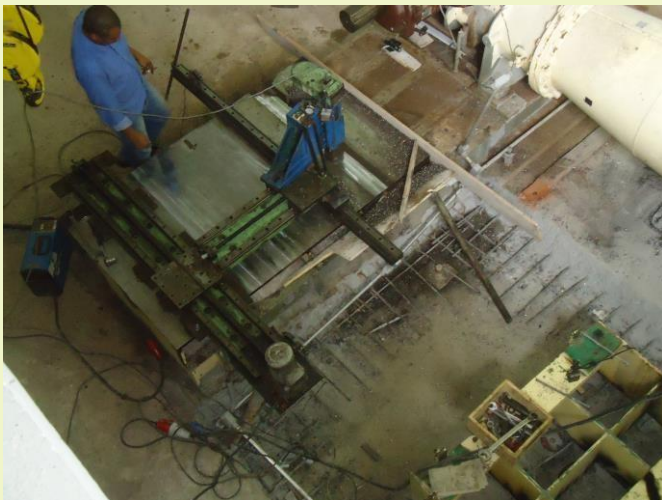
Fresamento de bases.
