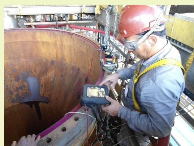
Alinhamento óptico de máquinas de papel
