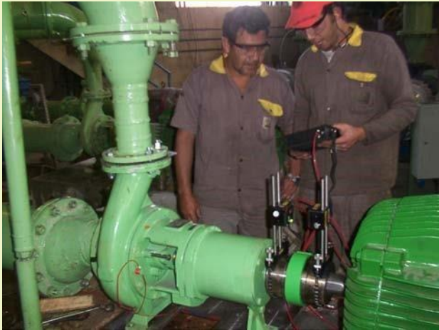
Alinhamento a laser de bombas e motores
