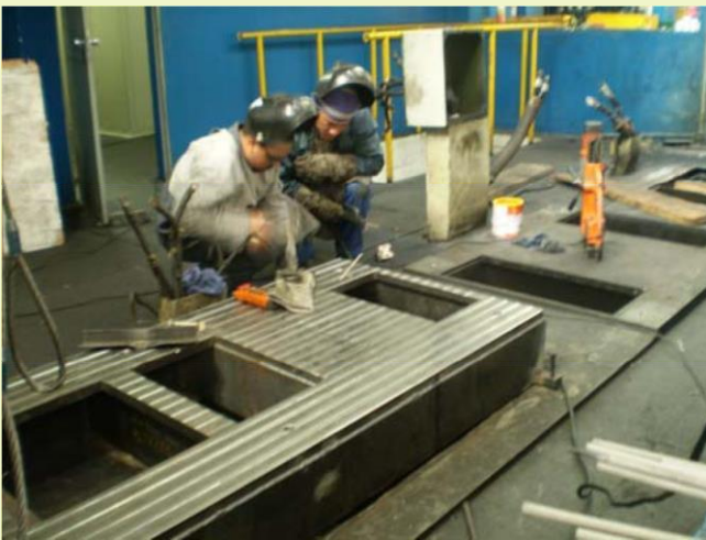
Fabricação e instalação de base para geradores
