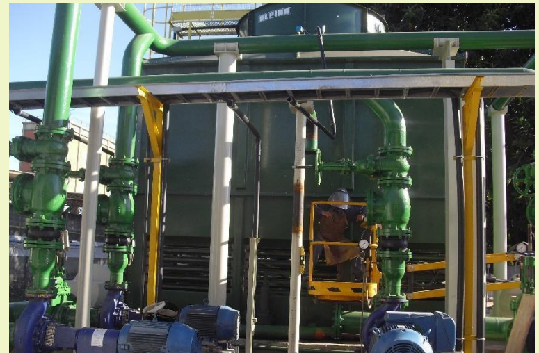
Fabricação, montagem e instalação de tubulações em aço carbono, inox, fibras e plásticas.
