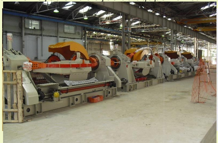
Instalação de linha de cordalhas
