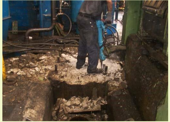
Reparação de bases industriais de máquinas
