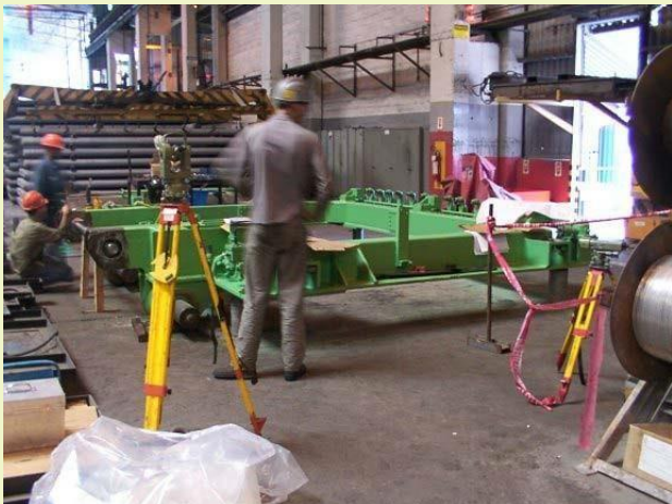
Alinhamento óptico de estruturas
