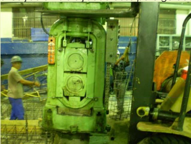
Instalação civil e mecânica de laminador
