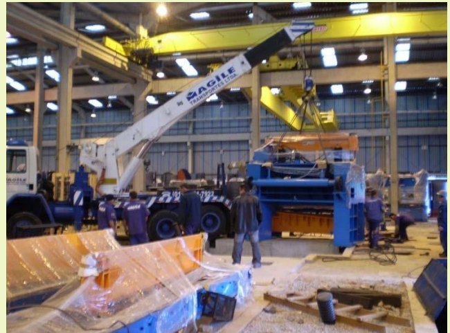
Instalação de linha de corte transversal de chapas
